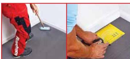
1. На чистый пол нанесите слой грунтовки под клеящий состав. В ванных комнатах слой грунтовки наносится на слой гидроизоляции.
