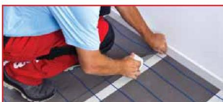
2. С помощью клапана коробки выполните разметку поверхности пола, выбрав необходимый шаг укладки из таблицы.
