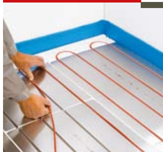
Укладка греющего кабеля
