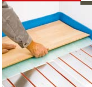
Укладка деревянного пола
