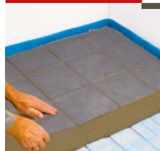
Укладка керамической плитки
