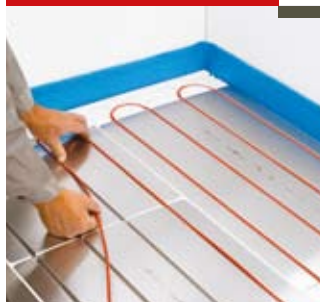
Укладка греющего кабеля
